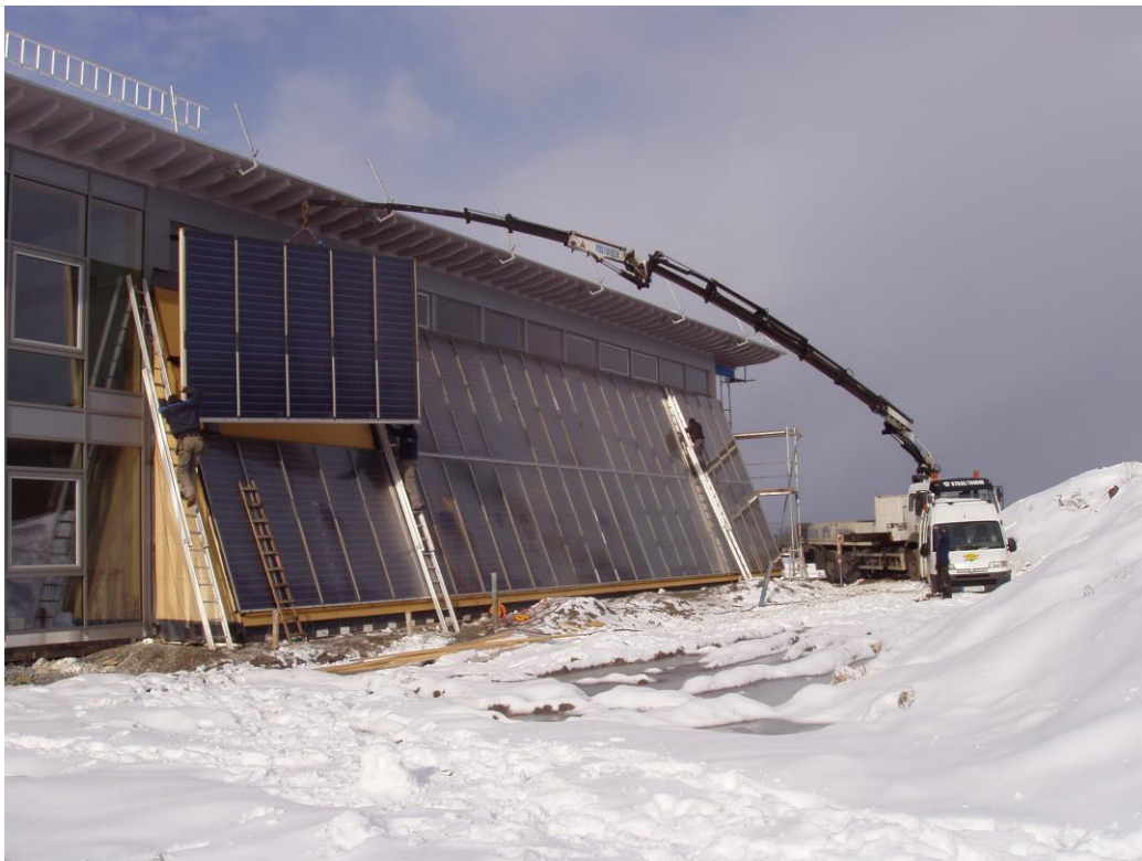
Einbau des Kollektors beim Sonnenzentrum in Oberndorf
