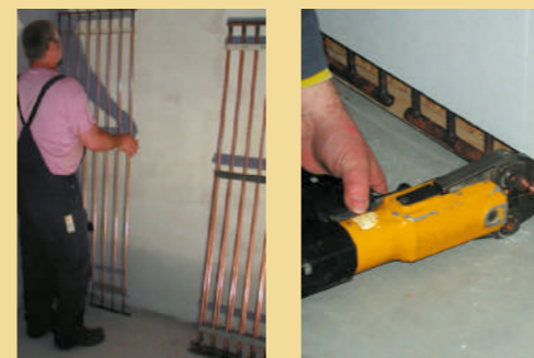
Unterputzregister aus Kupfer lassen sich mit Hilfe der mitgelieferten Montageschienen einfach an die Wand dübeln, verputzen und verbinden.
