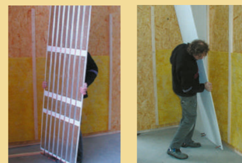
Für den Trockenbau sind Wandheizungspaneele aus Gipsfaser- oder Gipskartonplatten mit rückseitig aufgebrachtem Kupferrohrregister lieferbar.
